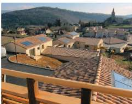
Saint-Julien-du-Serre, centre bourg Résidence les Bruges (réalisation Vivarais Habitat)
