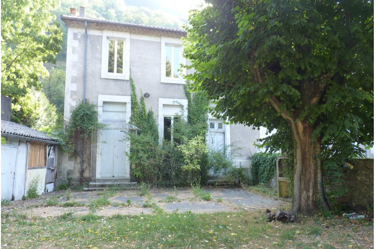
Logement communal à Laviolle – rénovation complète prévue en 2017
