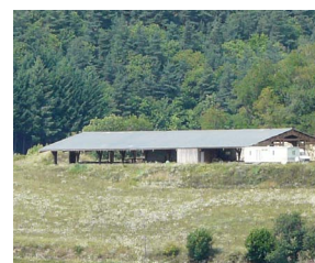
Charpente lamellé.collé et bac acier.
