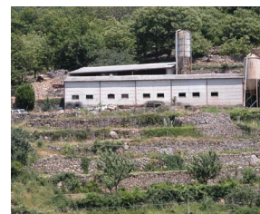
Préfabriqué béton et amiante ciment.
