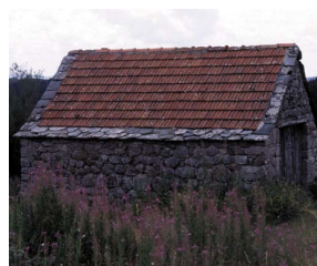
Pierre, tuile et lauze en couverture.
