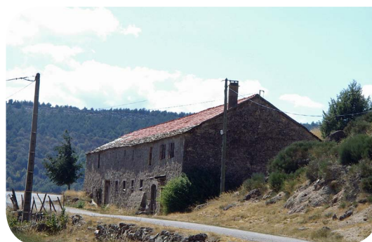
Bâtiment agricole traditionnel. Bâtisse simple et compacte en pierre, couverture en tuile, située en bordure de voirie. L'ensemble s'adapte à son environnement proche.
