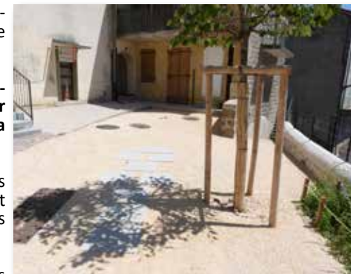
Aménagement d'un espace public mixte à Vals les Bains (végétalisation, surface perméable, jeux intégrés...)
