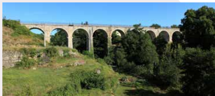
Continuité écologique identifiée (viaduc à Saint Etienne de Fontbellon)
