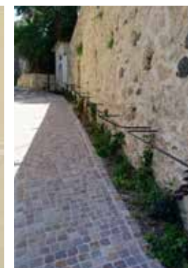
Pied de façade en "pleine terre" (Vals les Bains)
