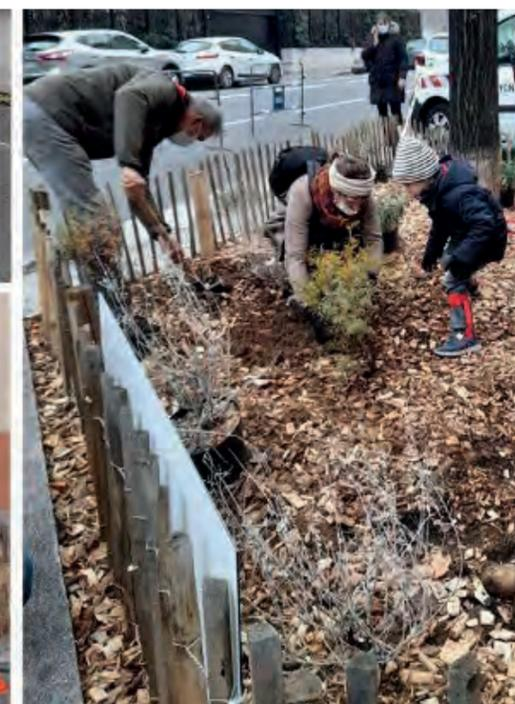
**Lyon quartier Vauban (6e).** Chaque fosse d'arbre permet de capter l'eau sur 100 à 150 m<sup>2</sup> de surface imperméabilisée autour de l'arbre. Les petites pluies seront ainsi infiltrées dans le sol et non plus envoyées à la station d'épuration avec les eaux usées. Le tout pour un coût moyen modeste de 3 500 € HT par fosse d'arbre aménagée. (cf financement)
