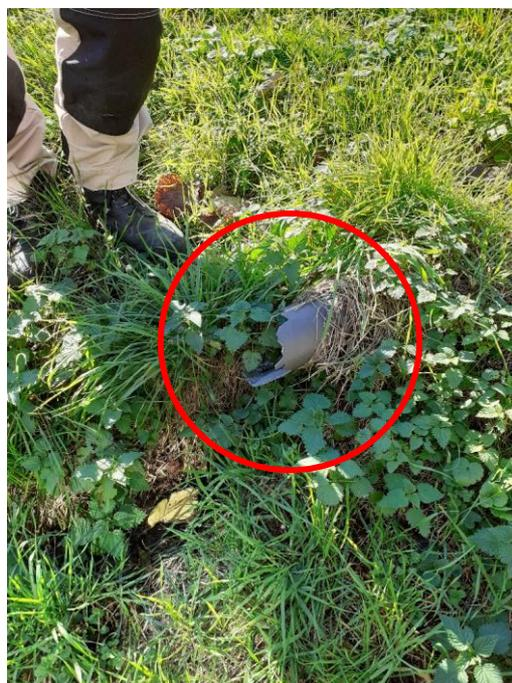
Rejet d'eaux vannes partiellement traitées en milieu superficiel dans une zone à forte pente proche d'un cours d'eau.
