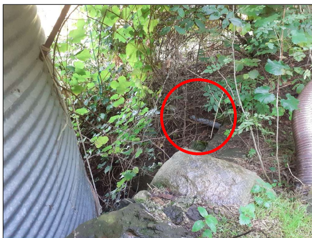
Rejet des eaux ménagères brutes (absence d'installation) et des eaux vannes partiellement traitées en milieu superficiel (à même le sol)
